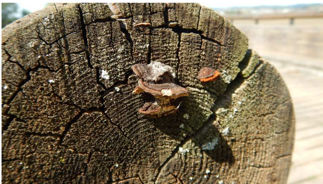
Obr. 9.1: Napadení trámovkou
