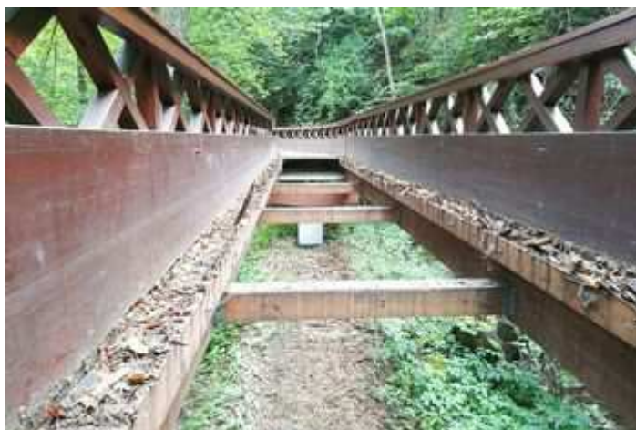
Obr. 10.1: Ukázka skryté poruchy měkkou hnilobou.
