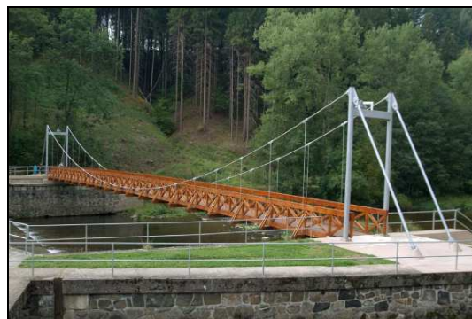
Obr. 3.2.5: a) zavěšená lávka a statické schéma (Zástřizly) b) visutý konstrukční systém a statické schéma (Semily)
