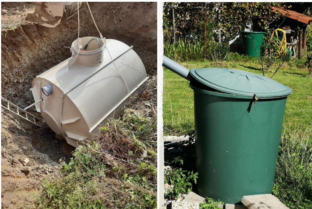
Obr. Akumulační nádrž na srážkové vody
