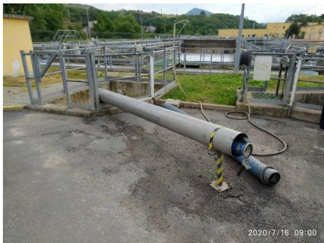
Obr. Zařízení k příjmu vyvezených OV z bezodtokových jímek na ČOV
