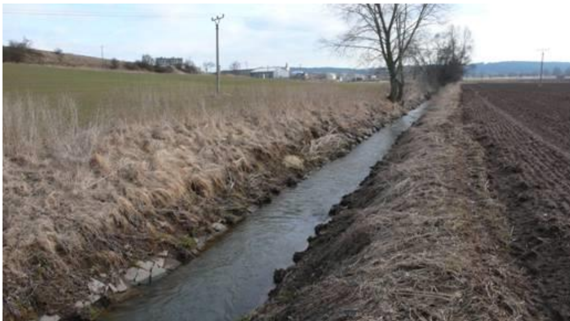
Obrázek 6 Hladké koryto vodního toku, kamenná dlažba
