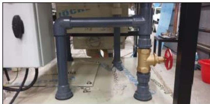
Obr. 2 Červený kohout bypassu se nachází vedle ovládání čerpadla.
