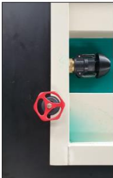
Obr. 1 Hlavní uzávěr přívodu; černý nástavec na obrázku je zmíněný tzv. obraceč proudu.
